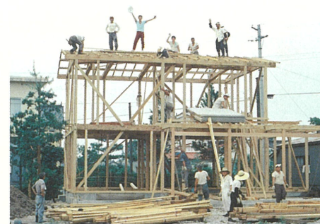
建設途中の若杉工場事務所
