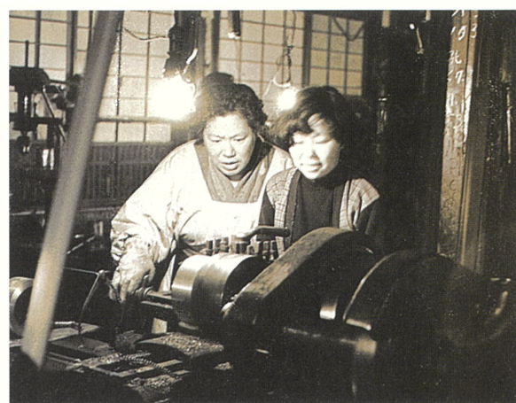
精一の妻光子が娘の悦子に、軸受用レースの旋削を手ほどき [昭和25年]
