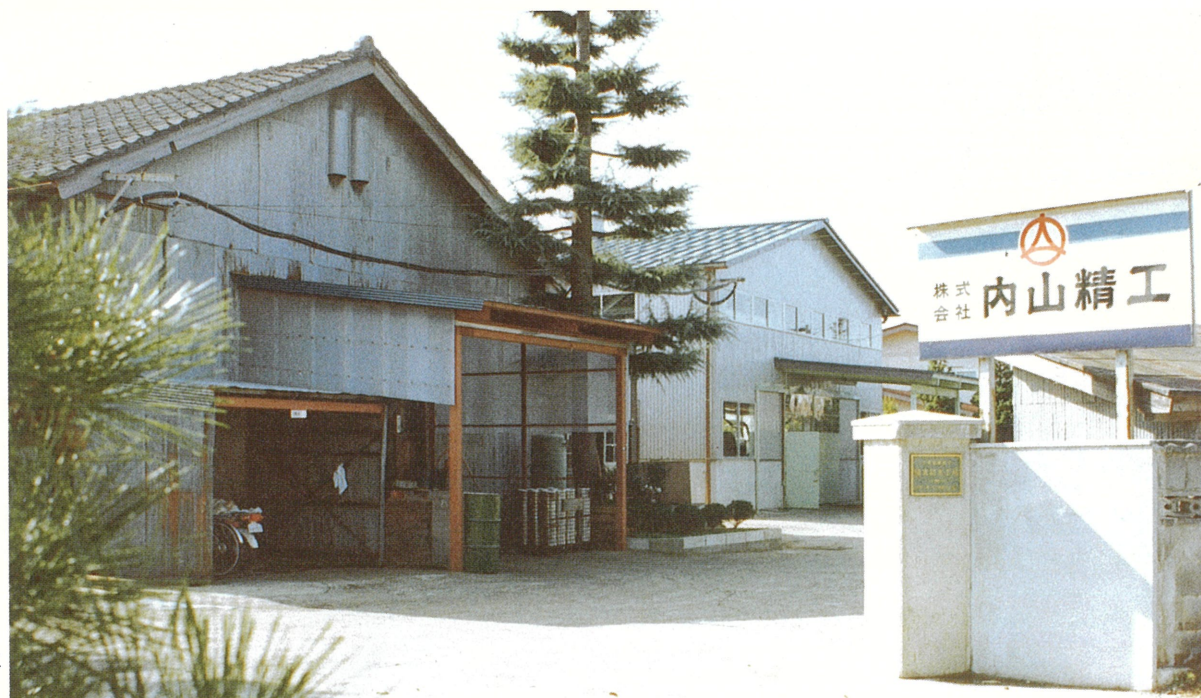
第2工場（中央奥） 完成後の内山精工 全景 [昭和56年]
