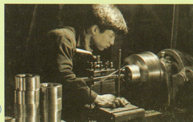
昭和26年 (1951年) 段車式ベルト掛け駆動旋盤 (写真7)
